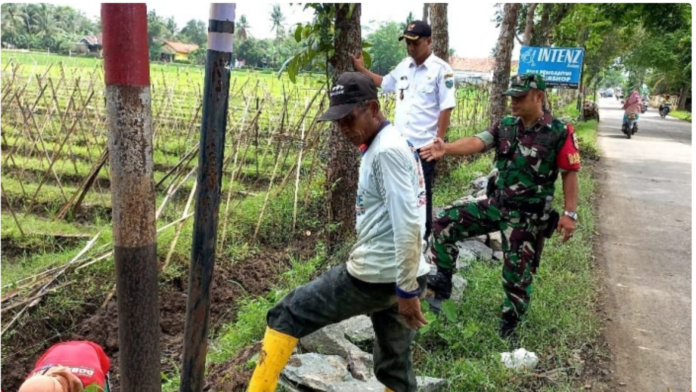
Babinsa Koramil 19/Kuwarasan Serda Jumadi dan Kades Kalipurwo Yuli Stianto melaksanakan pemantauan pembangunan talud jalan di dukuh Kalideres
